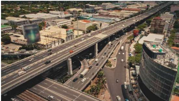
Sistemul de autostrăzi suspendate Metro Manila- Metro Manila Skyway System, Filipine cu o lungime de 39,2 km 4
